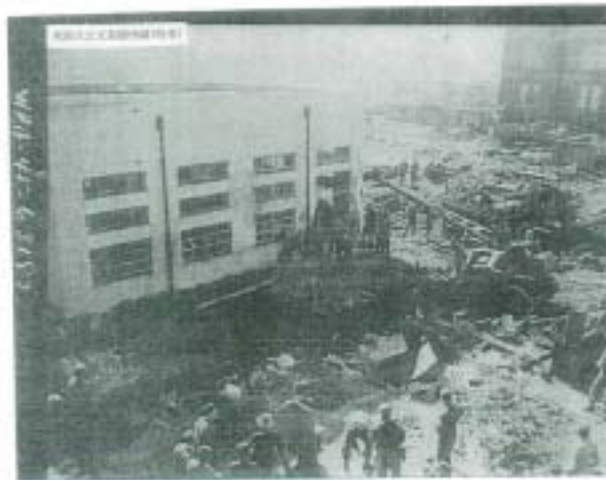
写真2 阪大サイクロトン建屋の壁をブルドーザーで壊し検収作業を検討しているところ 理学部中央棟の窓枠から撮影したと思われる 学園敷地を出ていた壁は全て壊されていて学園西側の視界が写っている ブルドーザーにて簡単な一瞬の破壊作業だった 作業を見物している理学部の研究者達の姿が写っている 検収作業は午前8時から始まり夕刻日没時までかかった
