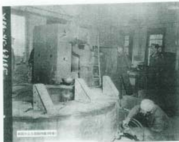
写真6 京大サイクロトロン解体作業 この写真にはコイル容器が写っている
