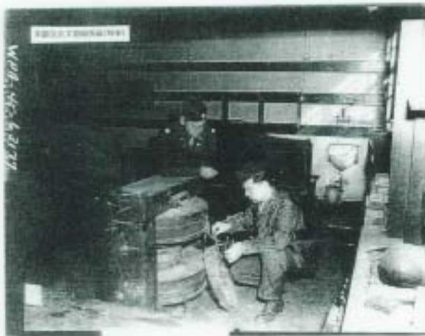
写真4 2台目の小サイクロトンと記録されたベータ線スペクトロメーター電磁石を調べているところ。軍需ZIMMERMANがノギスで主コイルの巻線寸法を測っているのを見ているのはAULL中佐。スペクトロメーター本体の真空槽は取り除かれてある。
