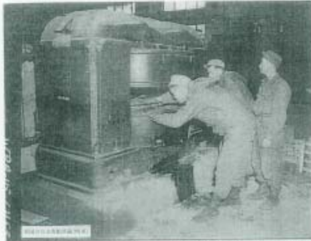
写真3 阪大サイクロトン電磁石の解体を工員が始めたところ。電磁石を基礎コンクリートに固定したボルトは爆薬でコンクリートを破壊して電磁石をブルドーザーで引きずり出した。
